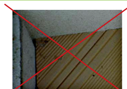
Nechte mezeru 5 mm mezi okrajem a 15 mm ode zdi
