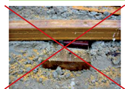
Nezalevejte nosníky do betonu
