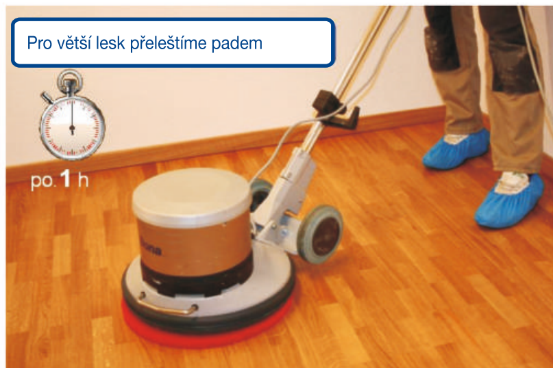
Rozleštění pomocí červeného padu a talířové brusky
